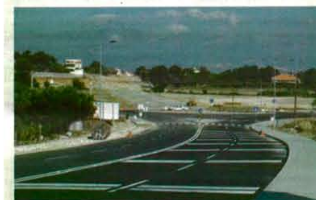
Primeiro troço da Circular sai da nacional 18 até à estrada de Valverde
